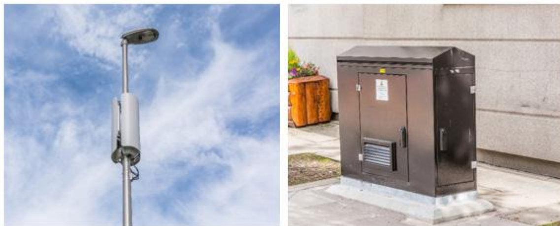
2.5-сурет – Шам бағанасында орналасқан антенна жүйесі және оған сәйкес сыртқы шкаф көрсетілген
